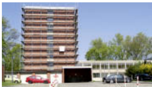
Vor 30 Jahren war das Schwesternwohnheim am Fichtengrund noch eine interessante Adresse – jetzt steht es kurz vor dem Abriss.
