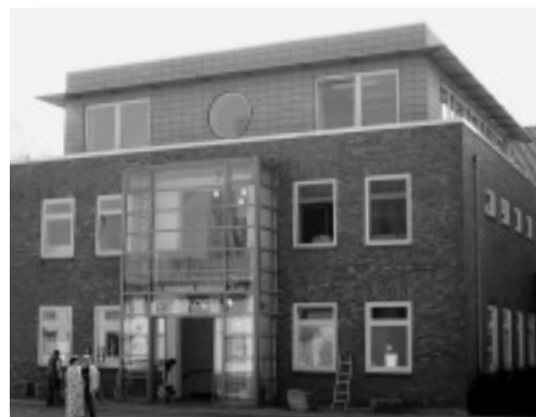
Neubau der Neurologie am Standort Salzdahlumer Straße.
