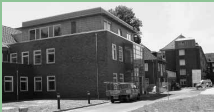
Der erste Bauabschnitt in der Neurologie wird Ende Juli 2005 abgeschlossen.
