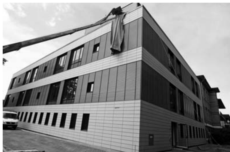
Am 25.05.2008 ist das Gebäude von außen schon fast fertig.
