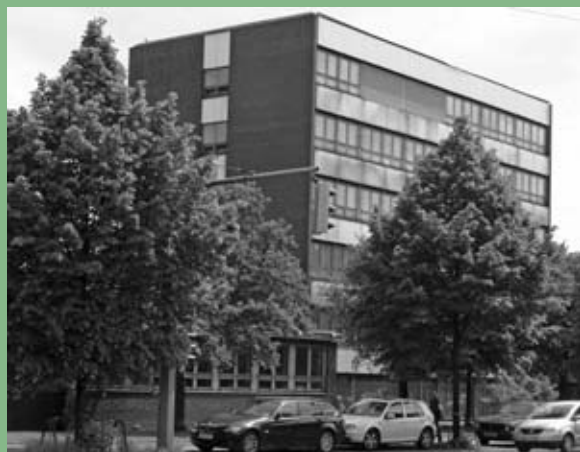
Dieses Gebäude baut das Klinikum zu Büroräumen um.
