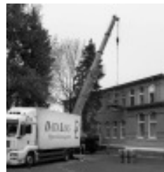
Nur mit Hilfe eines Krans konnte der ...
